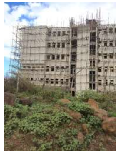
Das neue Universitätsklinikum von Bahir Dar. Das Baugerüst besteht aus Eukalyptusstangen.
