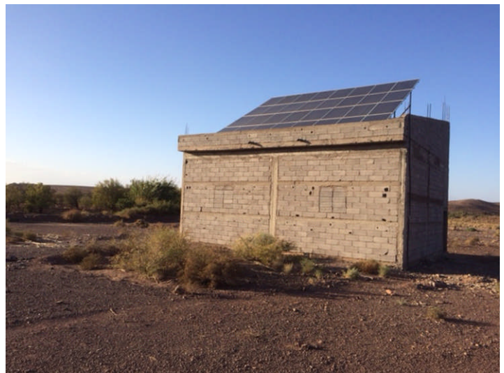
Das würden wir in Deutschland als Feldscheune bezeichnen. Auch dieser Bauer verwendet den Solarstrom zum Betrieb der Pumpe für die Tröpfchenbewässerung.
