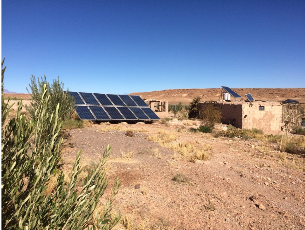
Ein typischer marokkanischer Bauernhof im Trockengebiet am Sahararand. Die großen Solarpaneele treiben Pumpen für die Tröpfchenbewässerung an; die kleinen auf dem Haus reichen für Beleuchtung und Handybetrieb.
